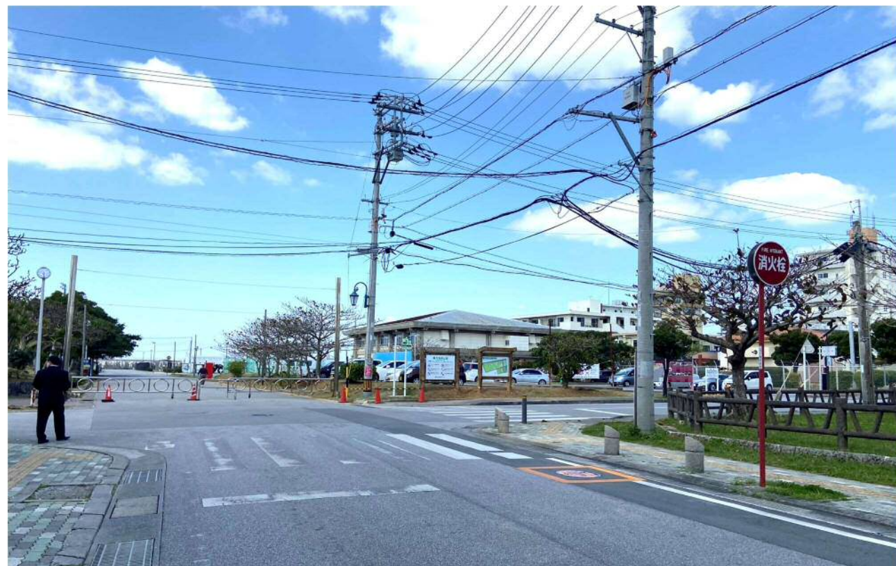
【現況】海浜公園東側入口から望む体育館
