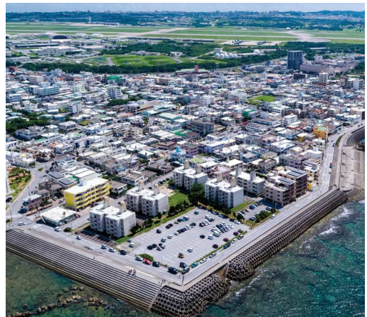
中層住宅地区としての土地利用を推進 (西浜区周辺)
