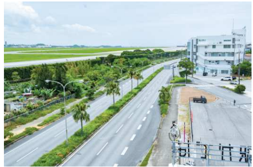
主要地方道沖縄嘉手納線（広域幹線道路）
