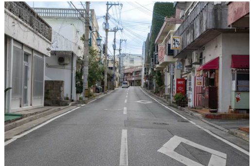
町道32号線（地区内幹線道路）
