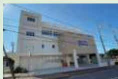
2 西浜区コミュニティセンター Nishihama District Community Center
